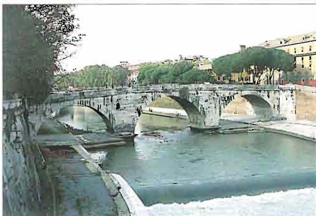
Figura 6 - Il ponte Cestio (1998).
