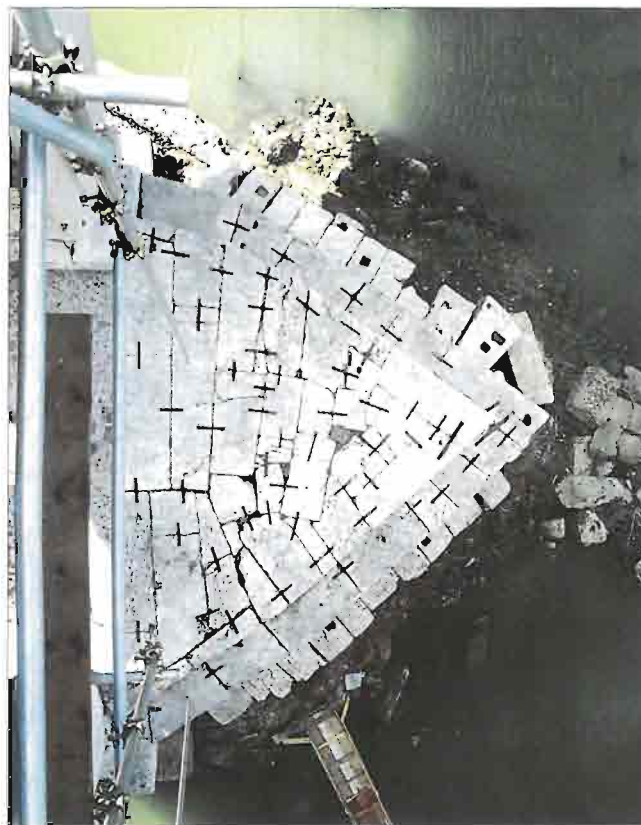
Figura 5 - Ponte Fabricio, superficie superiore della pila centrale.
