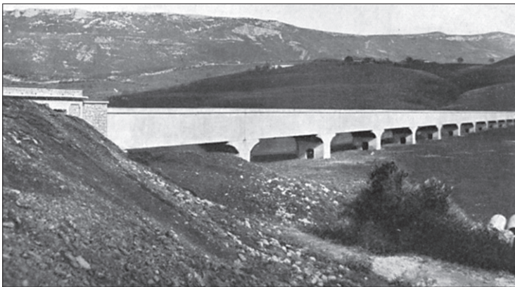
Figura 6 - Il ponte-canale per l'attraversamento della Valle del Quietto.
