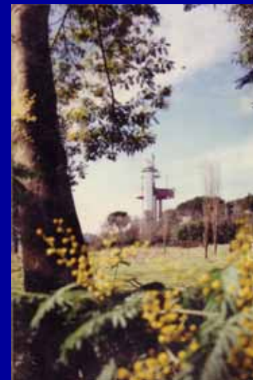
Veduta del centro idrico
